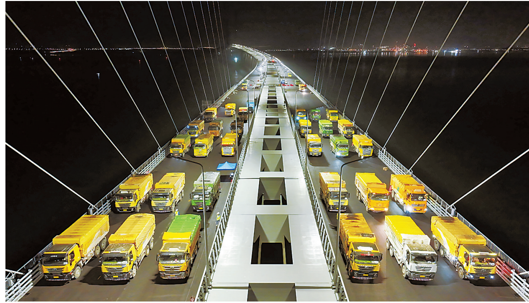
黄茅海 大桥静载试 验现场。 通讯员 郝笑天 摄
