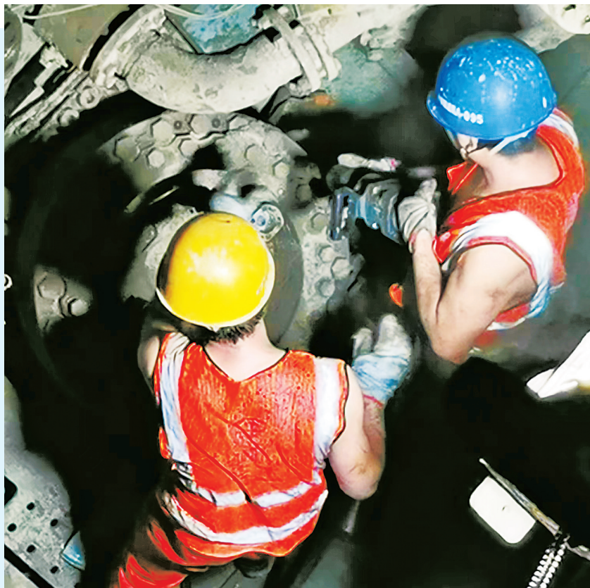
工作人员在下穿管道前停机换盾构刀片。
