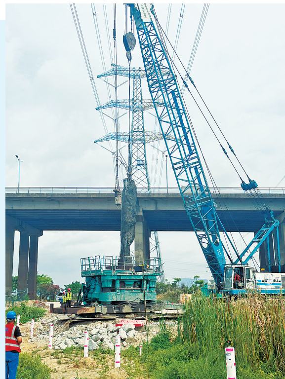
项目部用专业设备分段拔起障碍桩基。 (中铁隧道局珠海隧道项目部供图)
