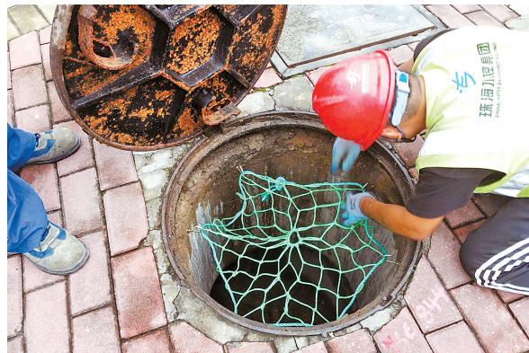
工作人员在污水井口加装行人防坠网。
