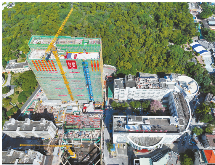
香洲区人民医院改扩建项目(二期)封顶。 本报记者 赵梓 摄
