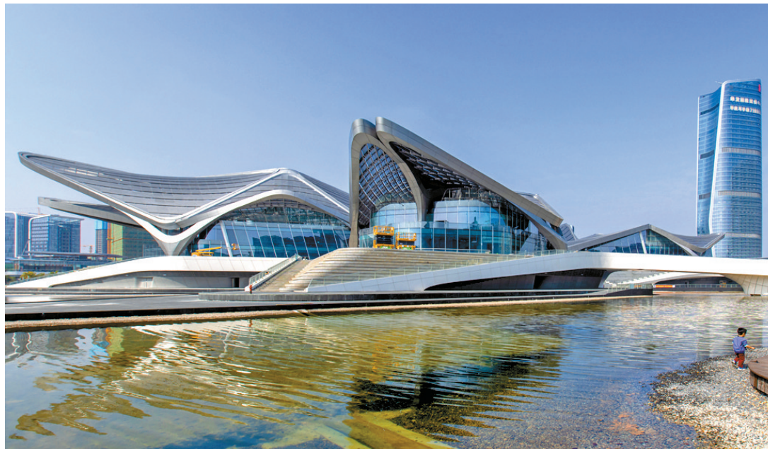
金湾市民艺术中心即将启用。 本报记者 梁冠贤 摄
