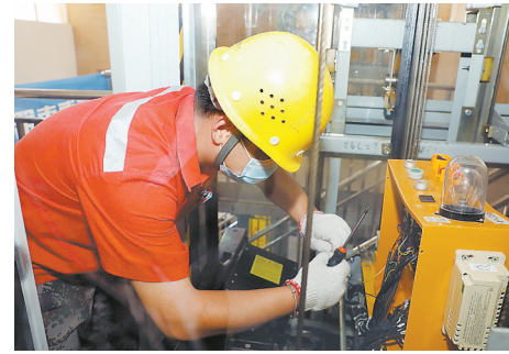
电梯维修保养竞赛现场。 本报记者 张洲 摄
