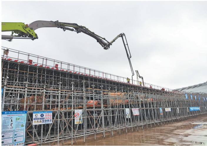
浇筑施工现场。 本报记者 陈颖 摄
