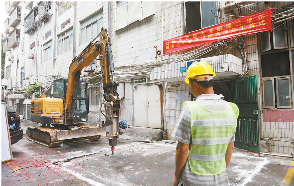
名都大厦副楼加装电梯工程开始施工。 本报记者 赵梓 摄
