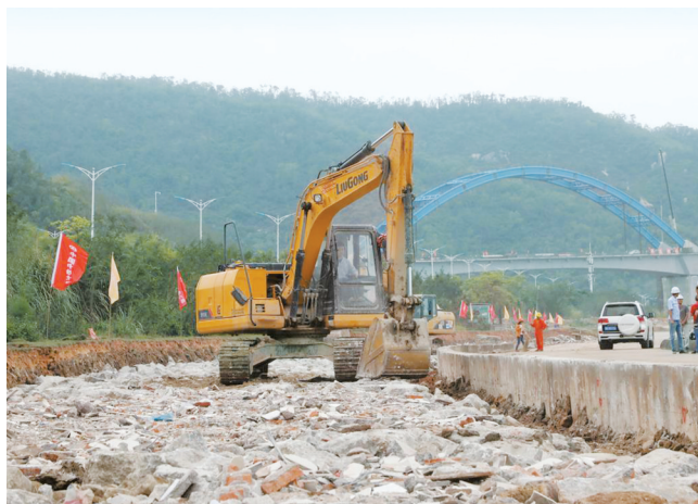
横琴环岛西路导改工程正在施工。 本报记者 曾遥 摄
