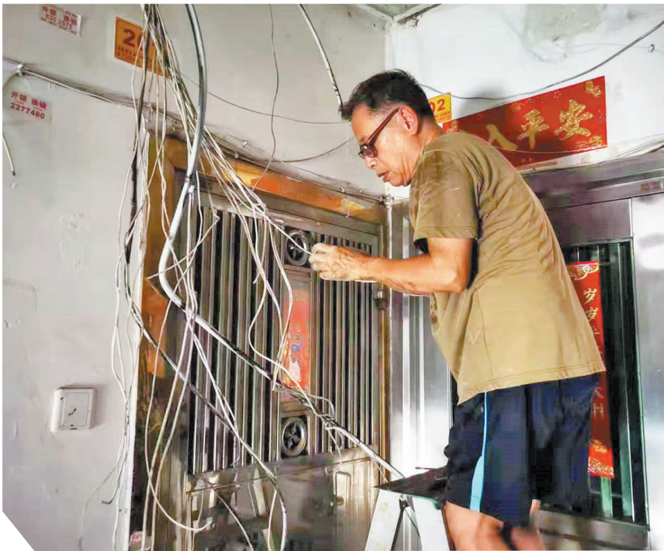
南美社区工作人员修缮楼道内损坏的电线,让楼道告别“脏乱差”。
