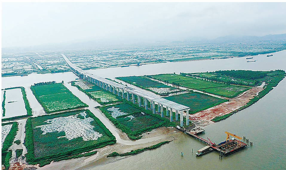
香海大桥4标段主体工程已经完工。
