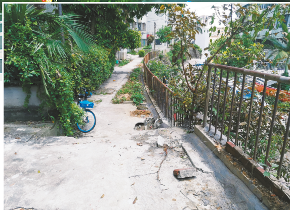
◀路灯设施未安装前。
