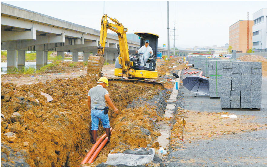
施工人员在红旗镇规划八路地下管网进行更新。
