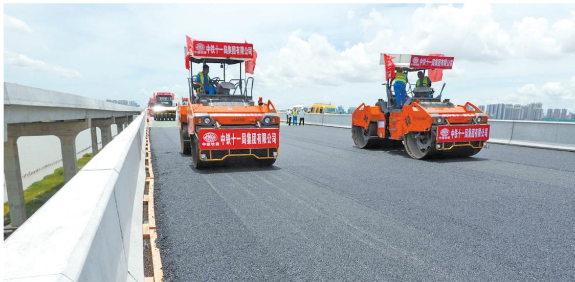
8月10日,洪鹤大桥路面沥青试验段摊铺作业现场。
