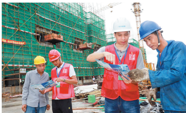
南峰社区党委书记张华基(右二)检查辖区工地。
