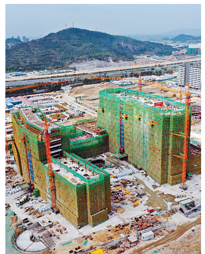
市慢性病防治中心项目主体工程封顶。本报记者 赵梓 摄
