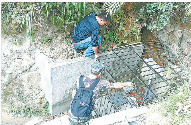
疏通水管后,工作人员将石溪最高处水管封闭,以防被再次破坏。
