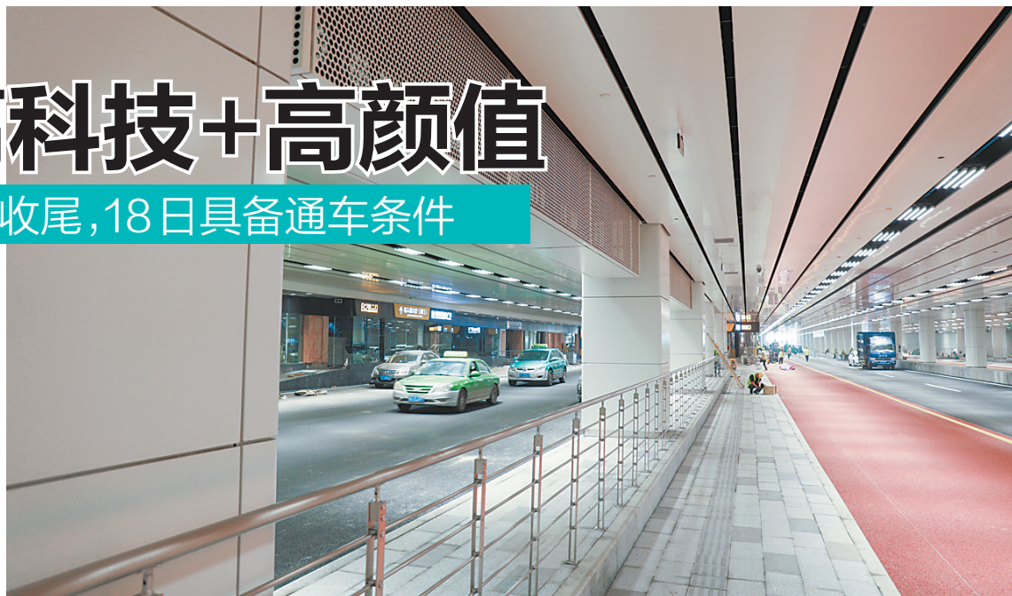
改造后,地下通道的通风采光大为改善。
