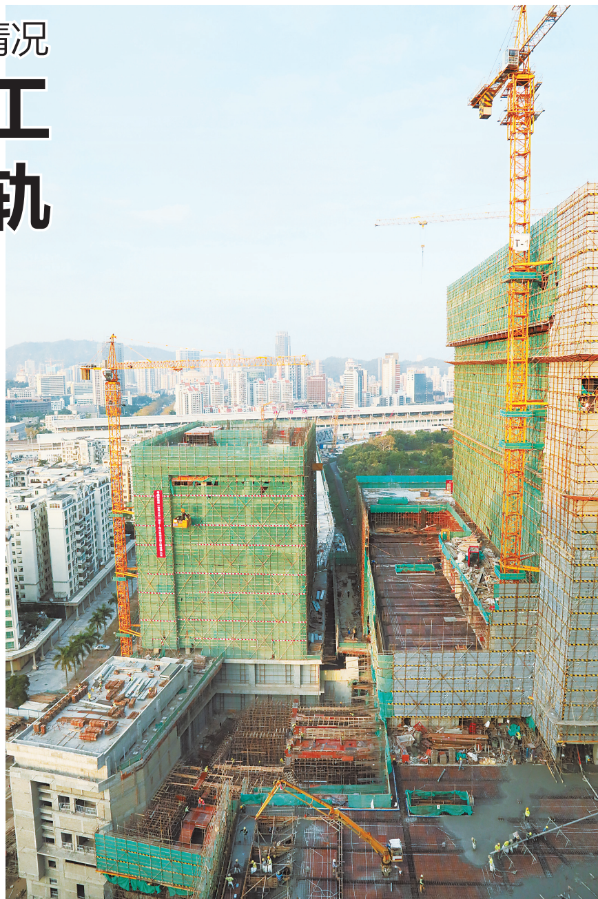
青茂口岸施工现场一片繁忙景象。
