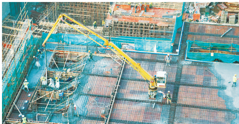
青茂口岸主体结构工程完工。
