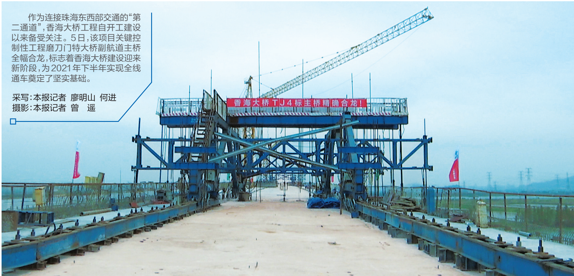
磨刀门特大桥副航道主桥施工现场。
