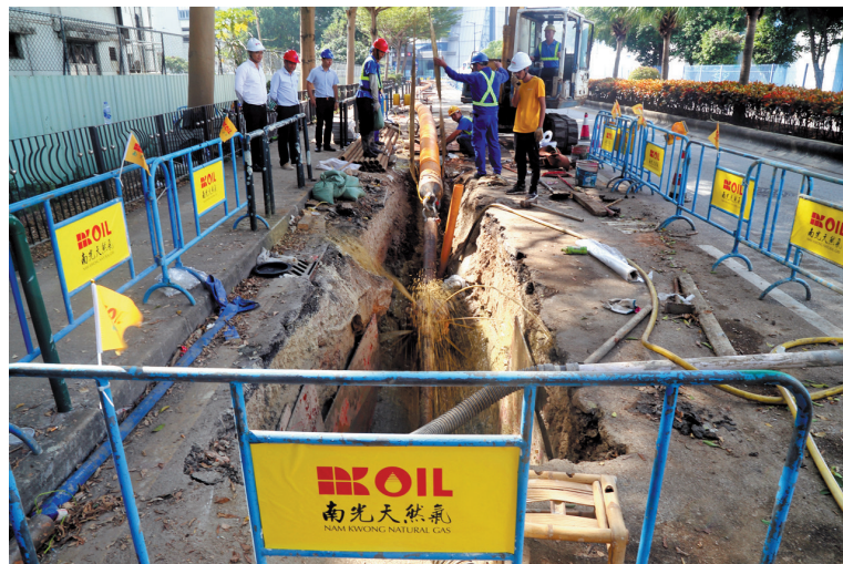
在拖管过程中,吸管吸收泥浆。 本报记者 陈新年 摄
