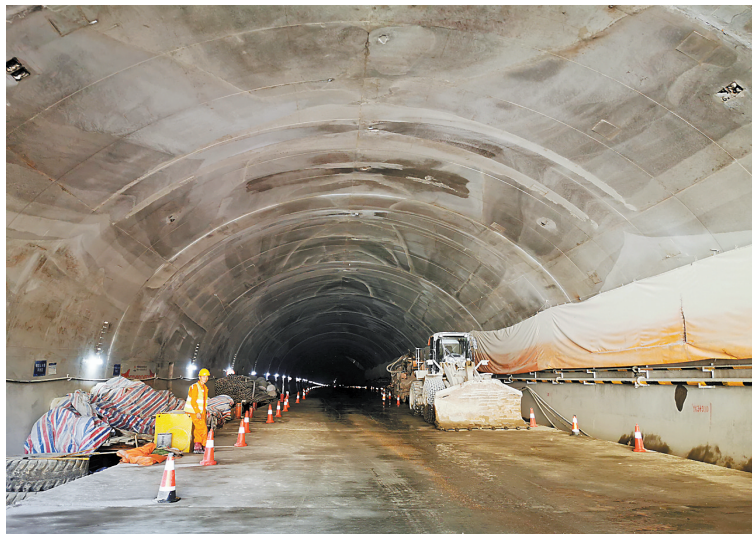
2号隧道右线施工现场。本报记者 郑振华 摄
