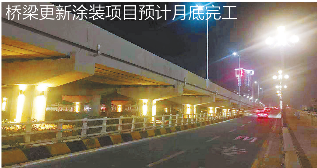
前山大桥部分墩柱和主梁砼表面已更新涂装。 本报记者 郑振华 摄
