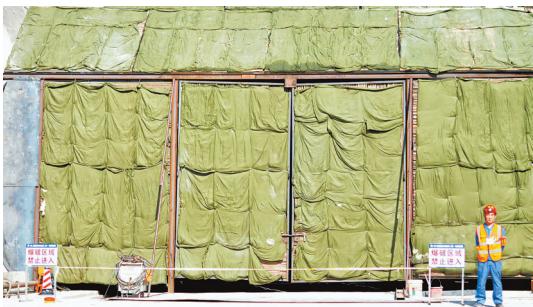
项目部在隧道口设置了隔离栏。
