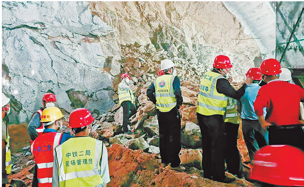
技术人员进入爆破现场进行评估。
