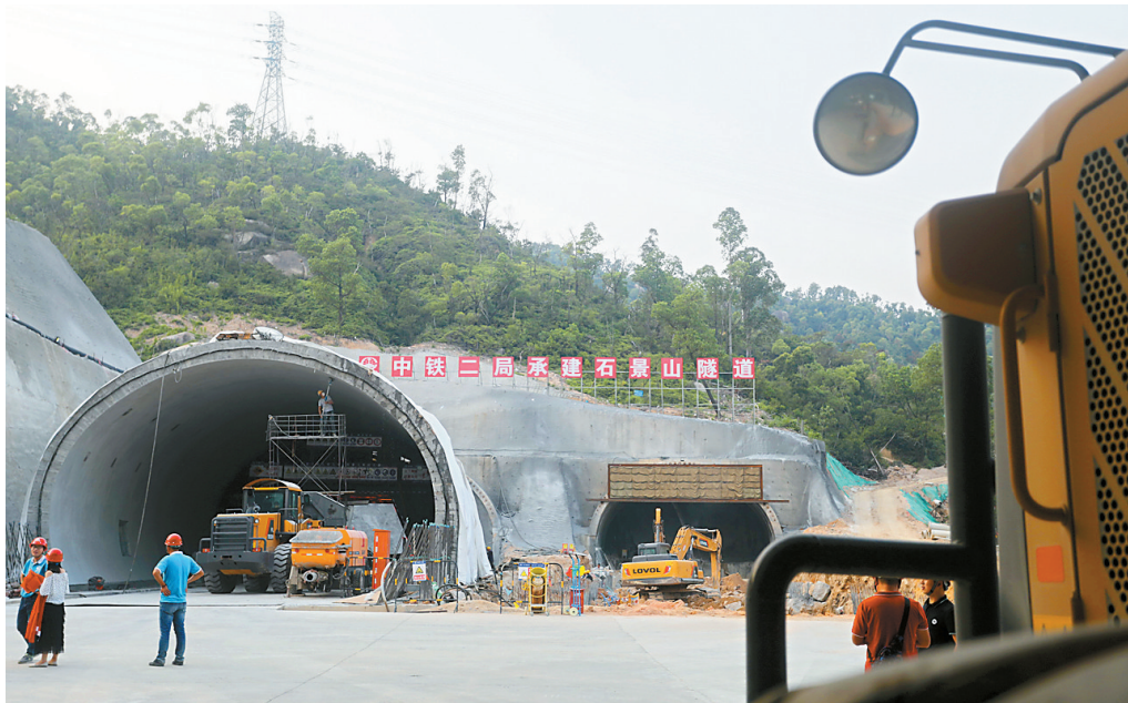
石景山隧道施工现场。本报记者 钟凡 摄
