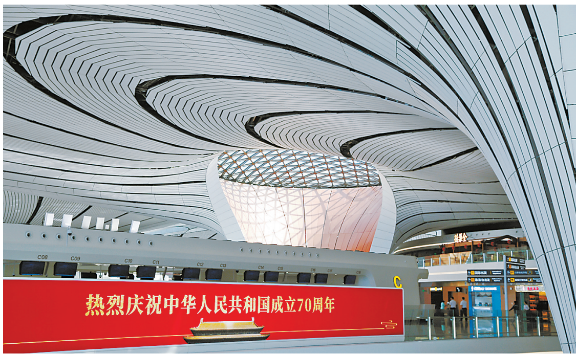
如参天巨树般的C型柱支撑起航站楼里的曲面屋檐。
