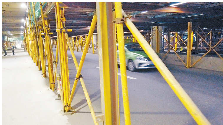
拱北口岸地下通道限高通行。
