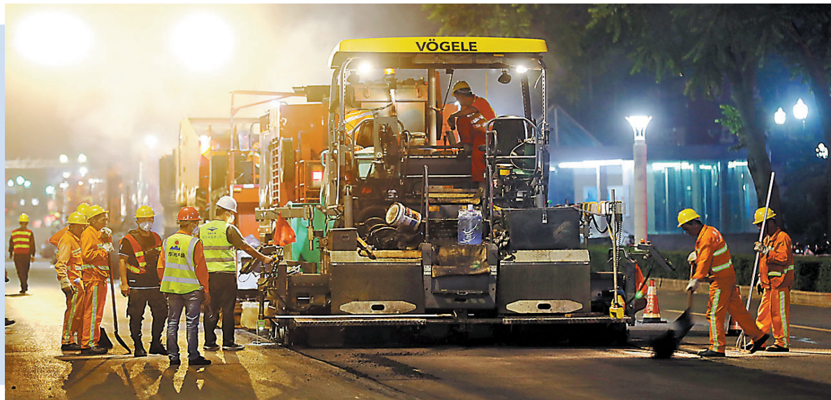
工人操作现代化设备进行施工。
