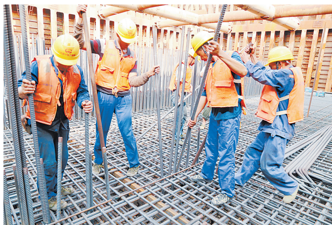
工人们在26号墩安装墩身预埋钢筋。本报记者 钟凡 摄
