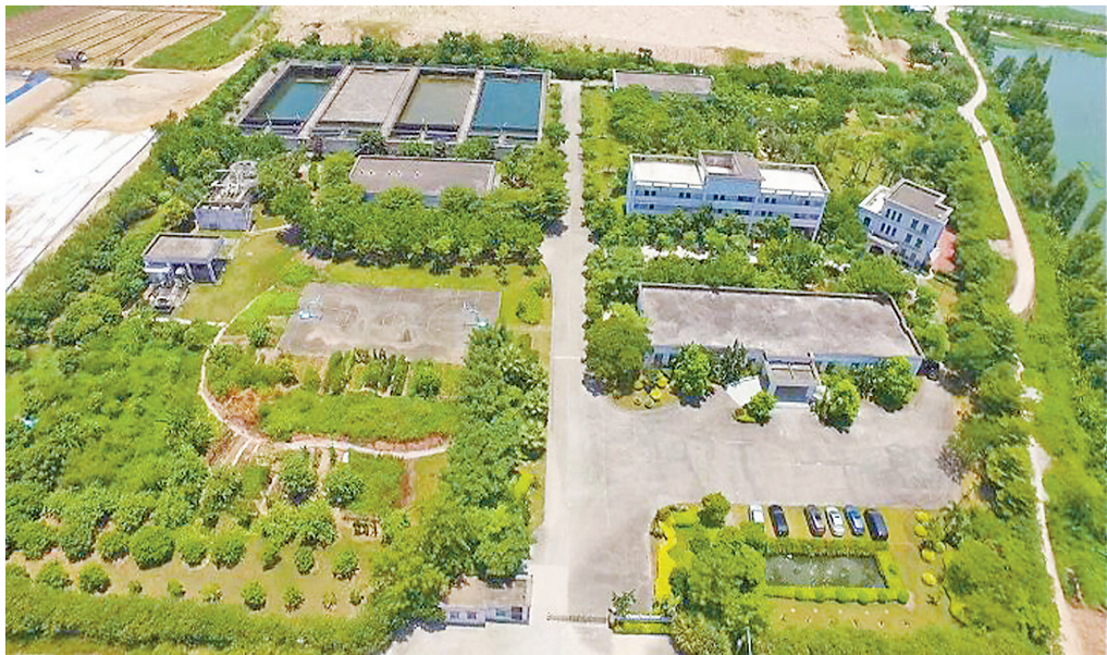
扩容后的井岸城区生活污水处理厂日处理污水能力8万吨。 本报记者 曾遥 摄
