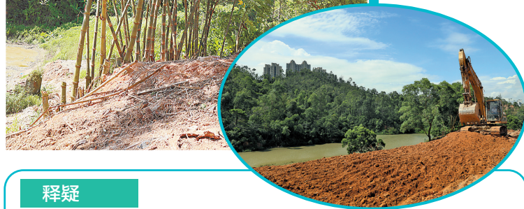
▼表层有养分的泥土做种植土,清表后再回填。
