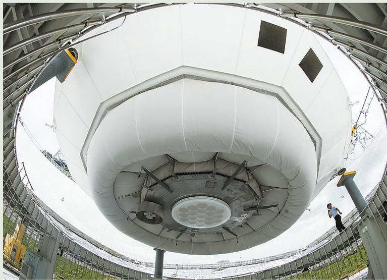
8月28日,工作人员在引导FAST馈源舱下降以进行检修。
