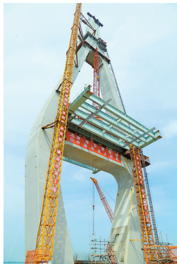
第一对斜拉索“穿针引线”完成。
