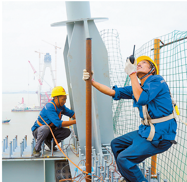
第一对斜拉索“穿针引线”完成。
