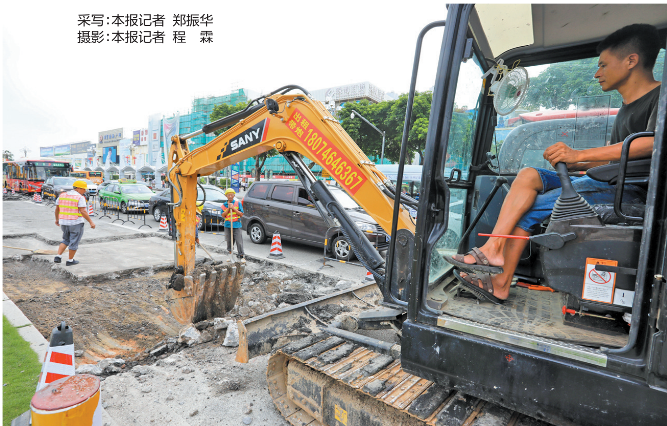
景山路施工现场。
