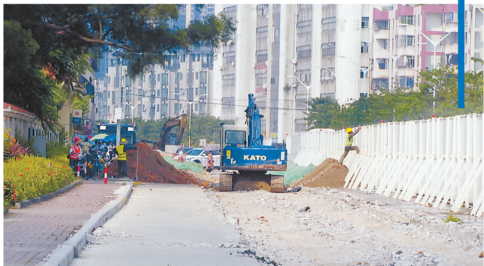
连桥路在施工建设中。
