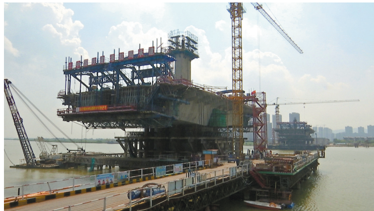
建设中的双湖路跨鸡啼门特大桥。
