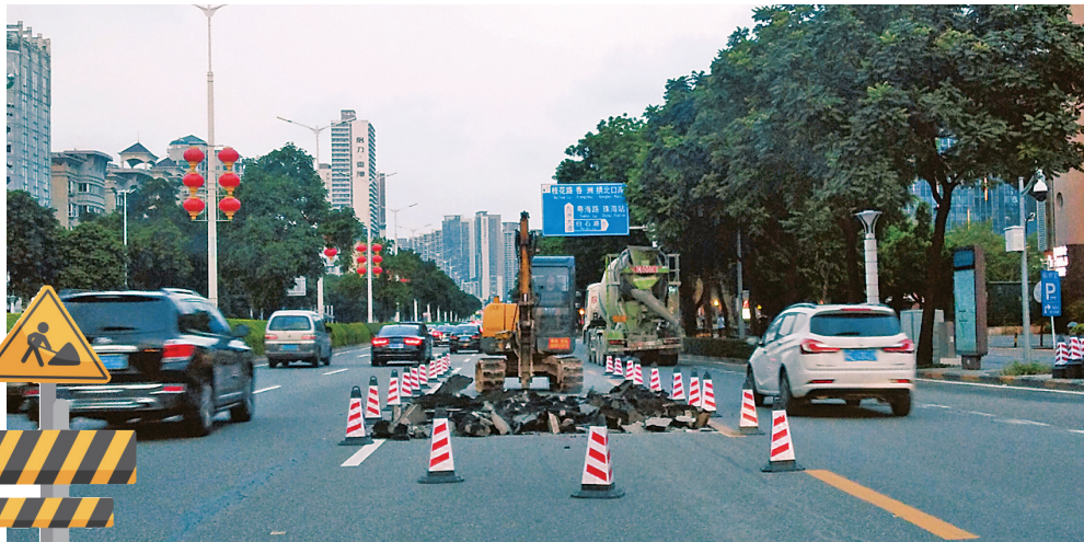
九洲大道开始进行道路病害修复工作。
