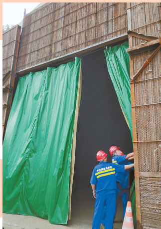
施工现场采用多重手段降噪除尘。
