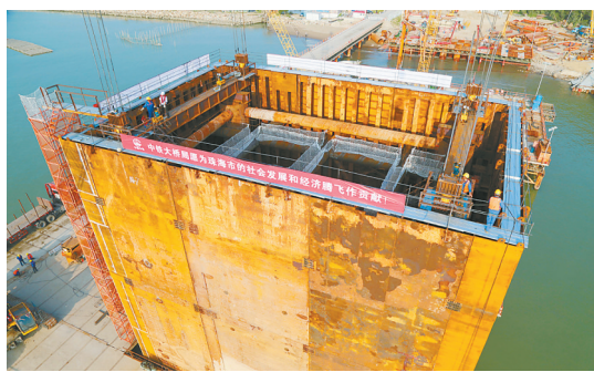
25号墩的围堰顺利下放到指定位置。
