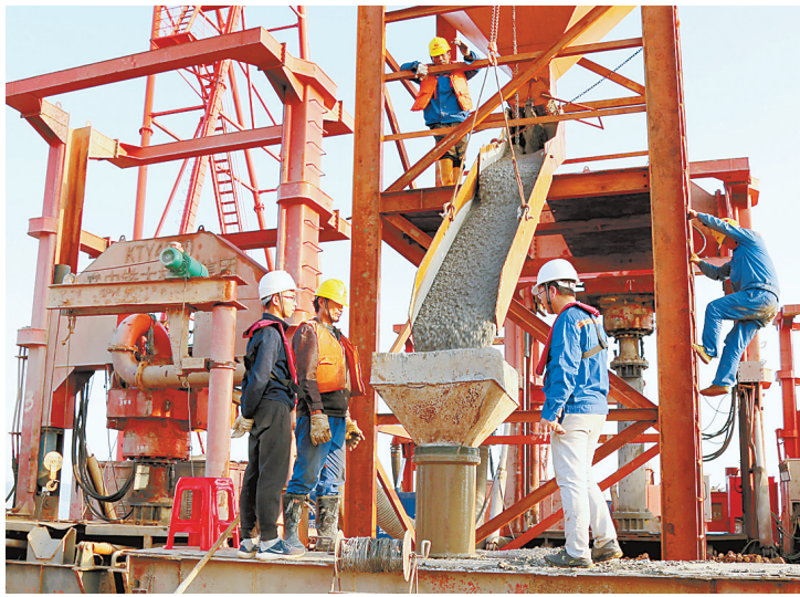
施工人员正在浇筑塔墩。
