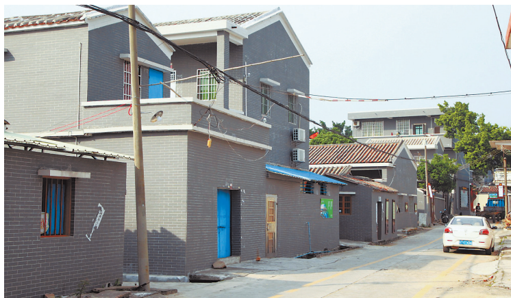
外立面经过改造的房屋焕然一新。本报记者 曾遥 摄
